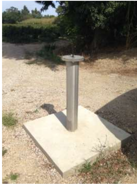
Illustration 1 Travaux de réhabilitation de l'ancien forage en piézomètre (Bompas Quaternaire) (photos décembre 2014)
